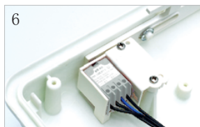
6 L'interruttore di distanza Ex de IIC opera attraverso un dispositivo di blocco e il coperchio può essere aperto solo quando l'interruttore è spento.
